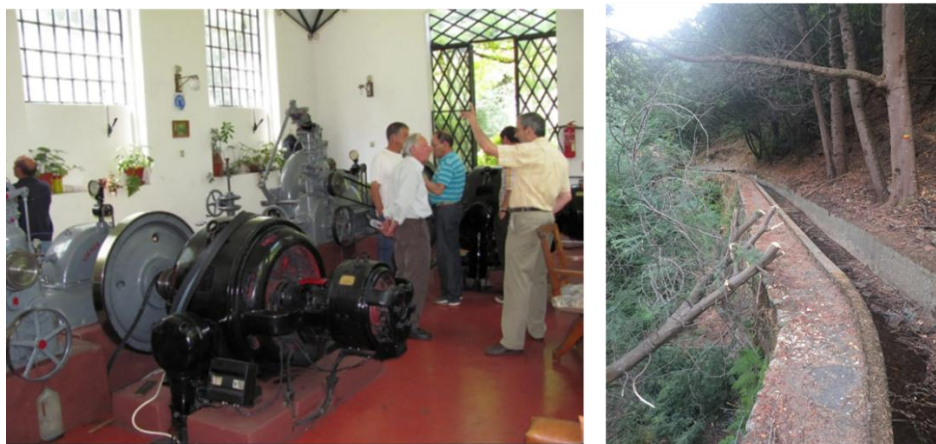
Figura-7: Mini central hidroelectrica da Ermida, que se encontra atualmente abandonada. Tanto o edificio da central (foto esquerda), como a levada (foto lado direito), precisam de ser reabilitados.
