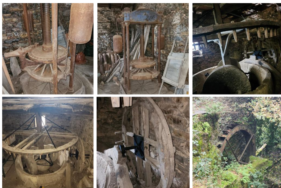
Figura-6: Lagar de azeite existente no Talasnal, com os seus equipamentos ainda intactos, cujo edifício necessita de reabilitação.
